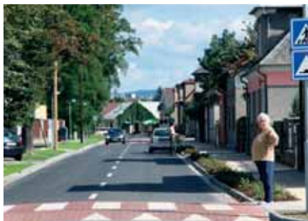
Letos byla mimo jiné opravena ulice Přichystalova. Značná část investic bude mířit do oprav komunikací a budování přechodů i v roce 2011.
